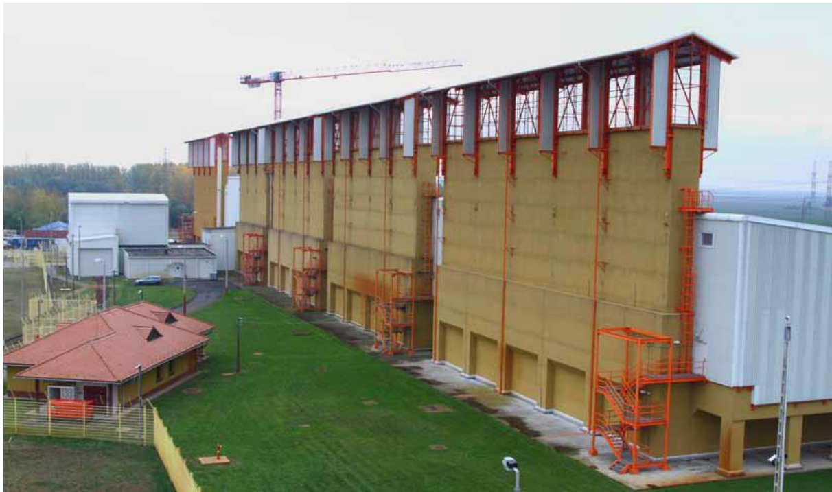
1.2-1. kép: A III. ütem 1. fázis építési munkái befejeződtek
